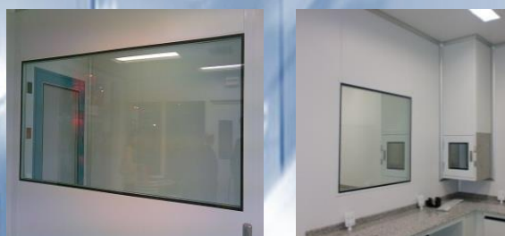
Visores com vidro duplo padrão GMP
