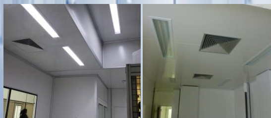
Luminárias de embutir com manutenção por baixo ou por cima padrão GMP
